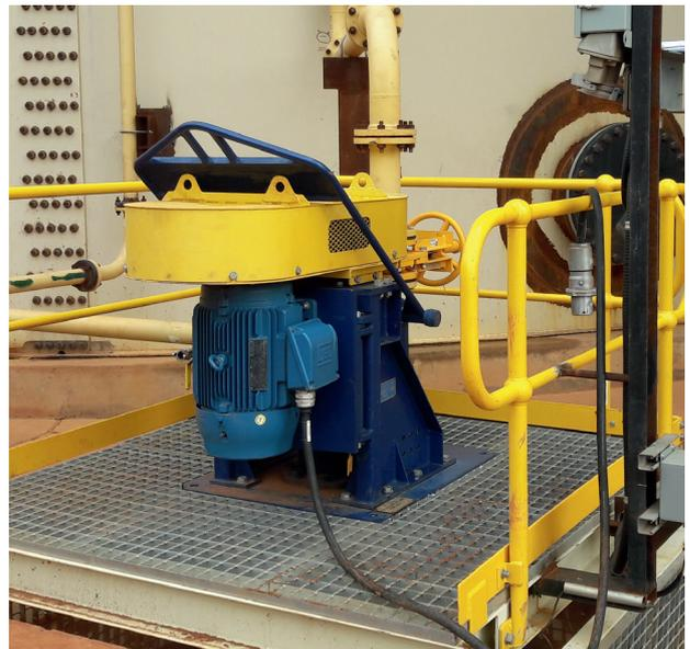
Installation de la vMAX™ avec configuration de montage de moteur standard. Autres configurations disponibles.
