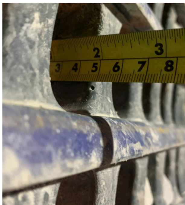
Inspecções frequentes e controle de produtividade
