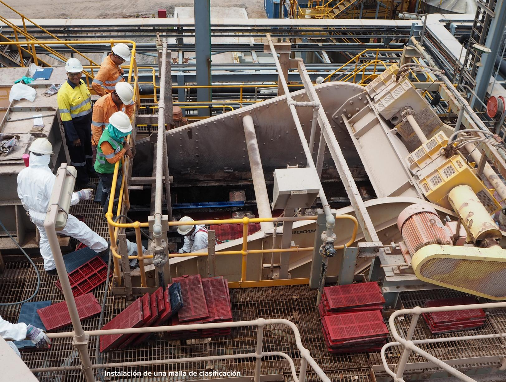
Instalación de una malla de clasificación
